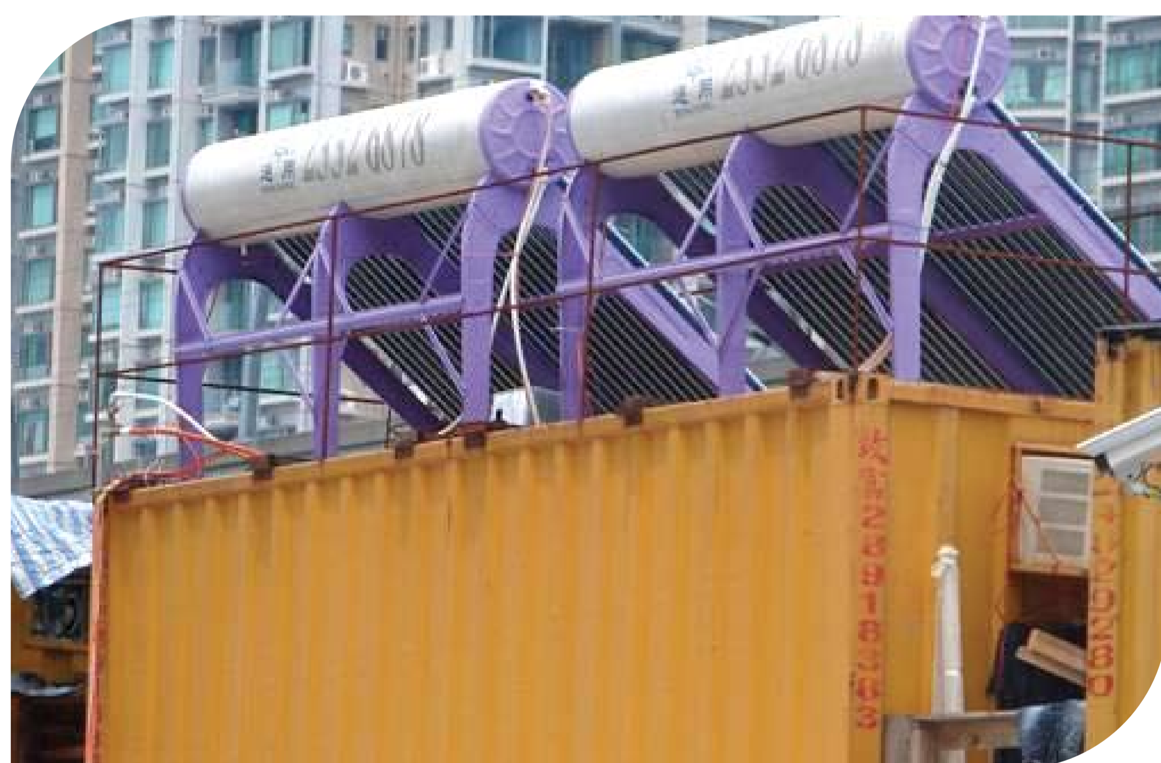
太陽能熱水器 Solar Water Heating System
