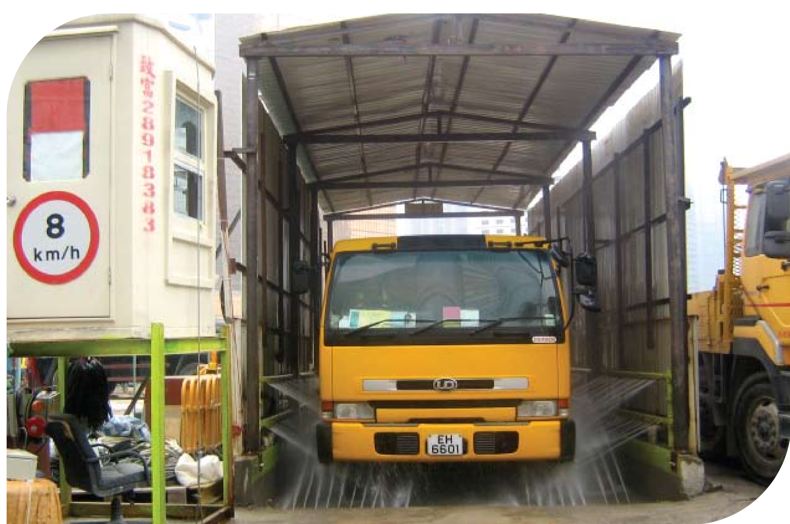
循環使用地下水以減低地盤塵埃。 Recycling of groundwater to suppress dust.
