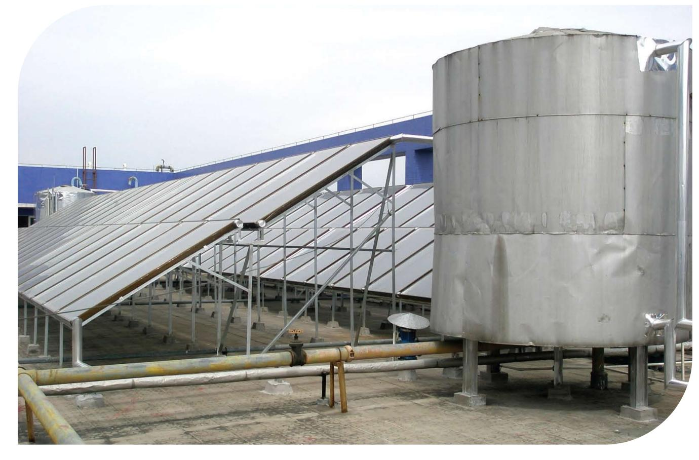
工廠宿舍全面採用太陽能製造熱水。2010年更將此技術全面應用於洗水生產,最終達致全廠熱水均使用太陽能升溫以減少能源消耗。
