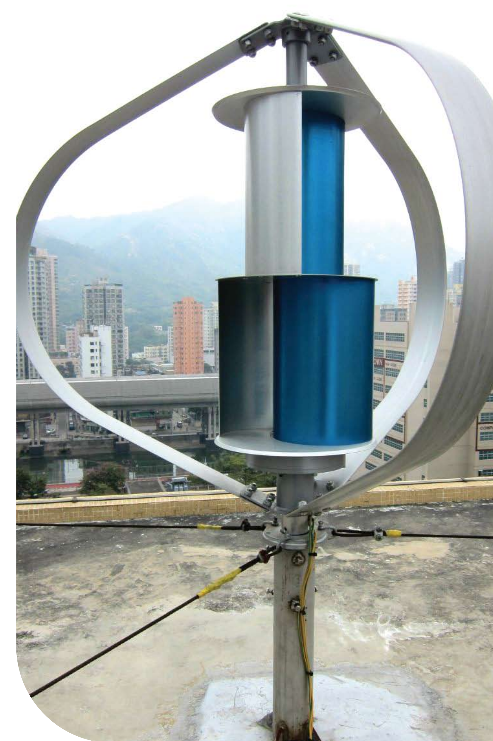
天台風力發電機 Wind turbine on the roof
