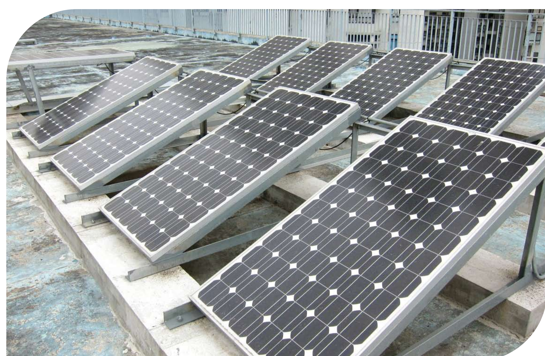
天台太陽能光伏發電板 Solar panels on the roof
