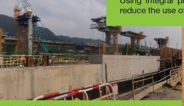
使用椿帽簡化及較淺層地基設計方案建造 隔音屏,減少混凝土的用量。
