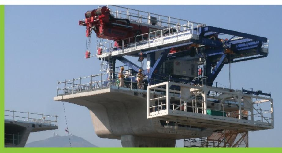
在行車橋設計方面使用整合橋墩與橋身接連方式設計方案,大大減少建築材料用量。
