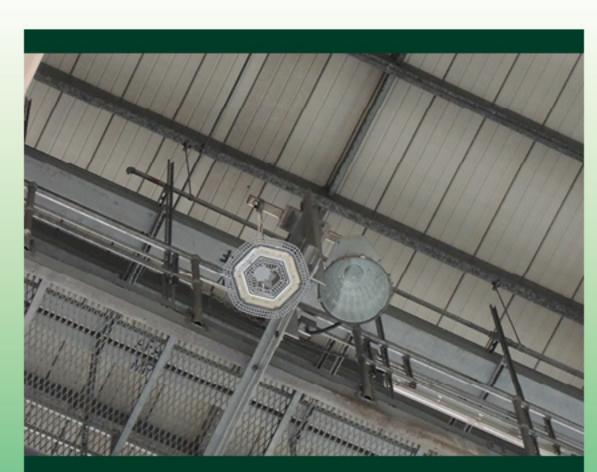
透過於機庫更換現有的高棚泛光燈為LED泛光燈及提高分體式空調機組的效率,以節省能源。
