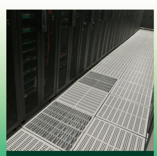
於數據中心的熱點調整空調閥門<sup>,</sup>提供重點散熱,從 而降低整體空調需求<sup>。</sup>
