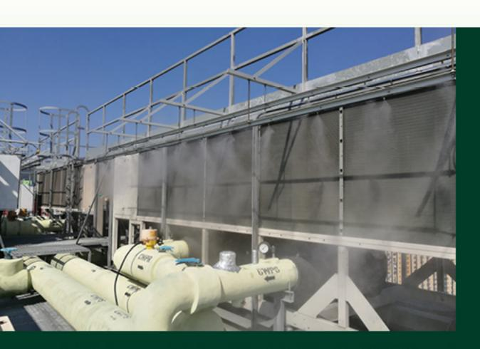
在數據中心屋頂安裝水霧系統,為冷凍機組提供散熱效果,成功節省約14%的能源。
