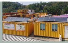
透過使用太陽能發光二極管戶外照明及已駁電網的太陽能板,減少對依賴化石燃料。
