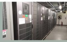
採用更高效能機電系統、不間斷電源系統及配電櫃內的隔離變壓器,讓數據中心達至更佳節能效果。
