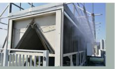
在數據中心的頂樓安裝水霧系統,為冷水機組提供 冷卻效果,節省能源消耗達14%。
