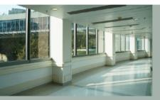
在幕牆安裝遮擋陽光裝置和雙層玻璃裝置,以減少 熱能滲透進入建築物,從而達致節能效果。
