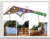
透過採用替代施工方法和設計,在挖掘及鋼管椿工程 時以壓實的泥土加上混凝土磚和鋼板作為平台,大量 減少木材使用和廢物。
