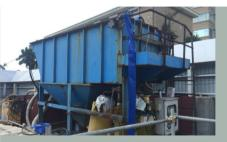
為減低對鄰近薄扶林水塘水質的影響,項目收緊對 水中懸浮固體物的監控、採用砂濾法,以及安裝化 學污水處理設施及實時水質監測系統。
