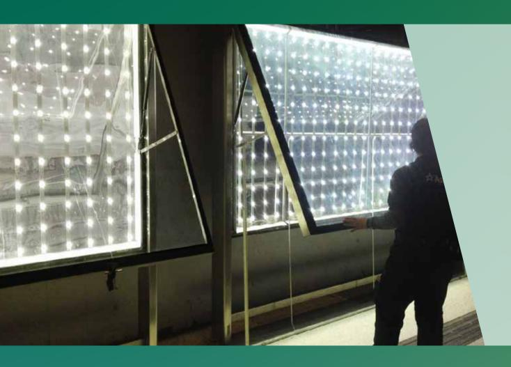
積極鼓勵廣告客戶及媒體商支持環境保護項目。例如得到 港鐵的支持及同意,在港鐵東鐵線、西鐵線及屯馬綫一期 進行廣告板升級及安裝工程,採用更省電的發光二極管照明 裝置,累計安裝超過1 100個二極管廣告燈箱。
