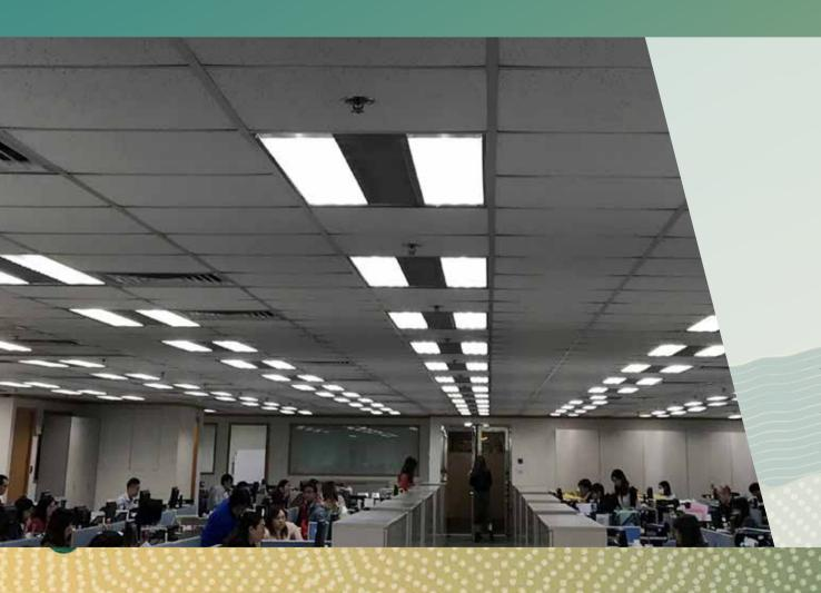
透過拆除三分之一的光管,為空調設置定時器,以及由節能團隊進行檢查,耗電量與2017/18年度相比減少了13%。
