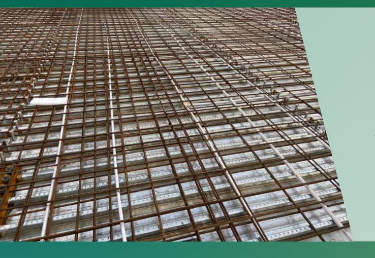
利用結構樓承板取代木板,並以金屬棚架代替傳統的竹棚架,以減少建築廢料。
