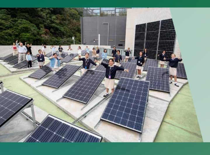
在學校其中一棟建築物的屋頂上安裝72個微電網太陽能板和儲電系統,其產生的電量可供三個課室及學校飯堂的冷藏庫和冰箱使用。
