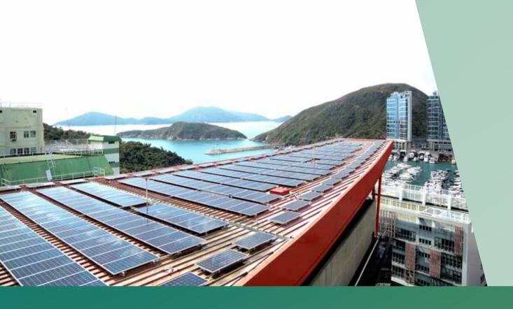
在小學校舍及李東海藝術中心的屋頂上安裝連接到電網的大型太陽能光伏系統,供電量可達133 000度電。學校亦安裝了實時能源監控系統和顯示板,以便分析及與學校成員分享實時能源數據。
