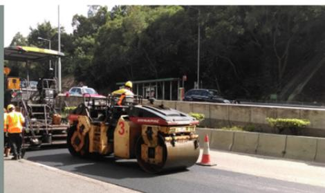
本項目於施工期間只需要較少的熱能以作物料混合及壓實工序，因而降低對附近環境造成的空氣污染及相關滋擾。施工期後，本項目亦較傳統瀝青路面減少路面噪音達三分貝。
