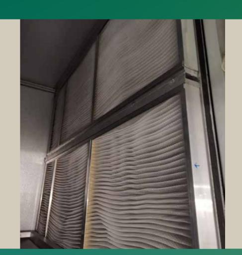
產品由一個或多個聲波產生器在空氣過濾器介質層的底部組成。當在暖氣、通風和空調系統使用時,產品可透過利用聲能引起灰塵顆粒快速振動和促進顆粒滲透到過濾層中,以提高過濾效率。
