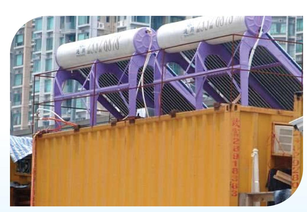
在員工宿舍安裝的太陽能熱水器所產生的熱水,足以供600個員工同時使用。
