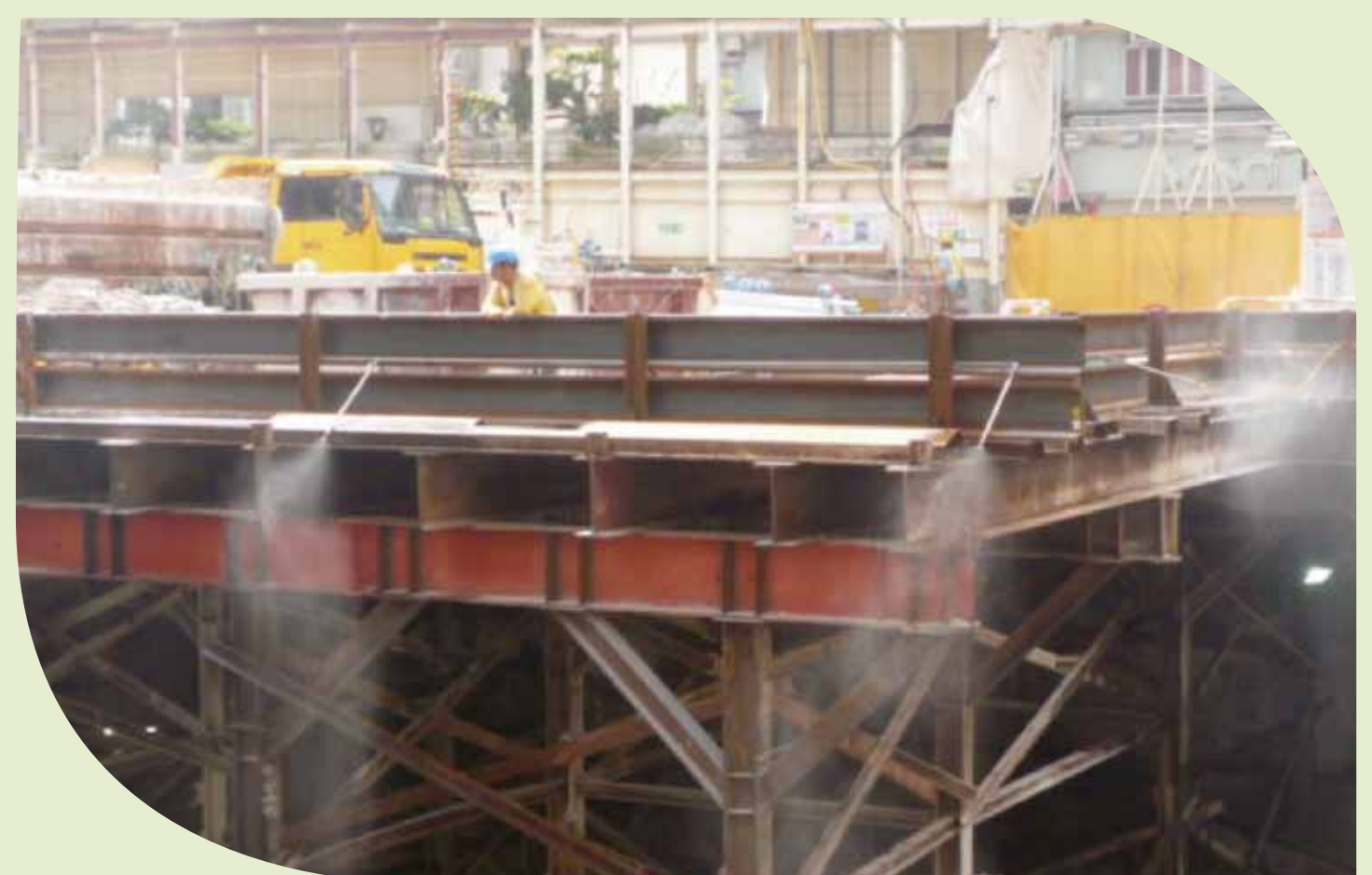
使用噴霧系統以減少工地散發塵土 Using mist sprayer to reduce dust emission
