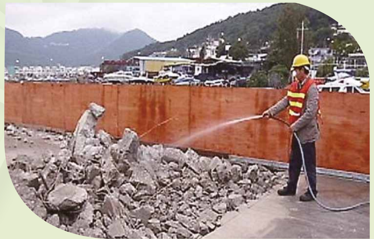
在進行容易產生塵埃的工序時，弄濕工作的範圍。 Watering to reduce dust emission during demolition works.
