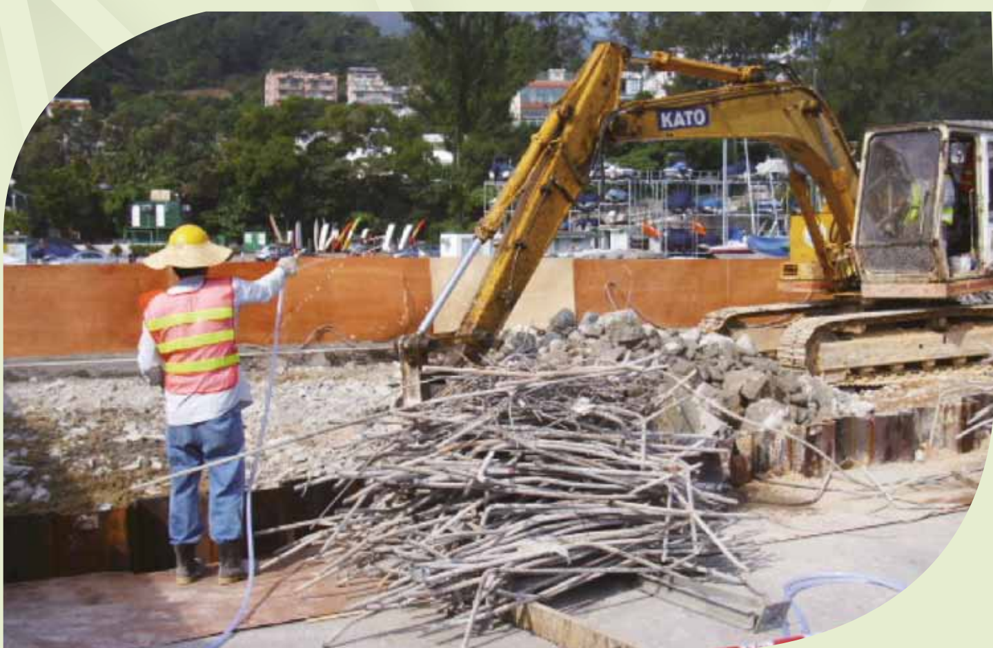
把廢鐵與混凝土分開，以便循環再造。 Extracting steel bar from concrete for recycling.
