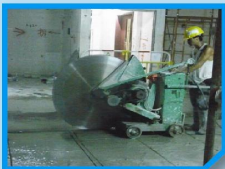
在地下室採用鋸切的方法，盡量減少塵土污染。 Adoption of saw cutting method at basement to minimize dust pollution.
