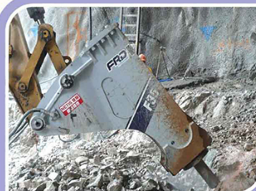
於香港公園工地使用超靜音液壓破碎錘，減低噪音6分貝。
