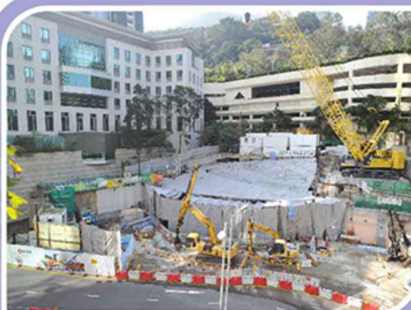
為香港公園工地豎井挖掘工程特別建造臨時隔音罩，以減低5分貝的噪音。
