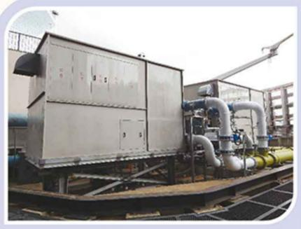
以水冷式冷氣系統取代風冷式冷氣系統,提高冷氣的傳送 效率及冷凍容量,達致更佳的節能效果。
