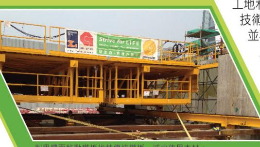
利用樓面移動模板代替傳統模板,減少使用木材。 Using travelling formwork for floor slabs to save timber usage
