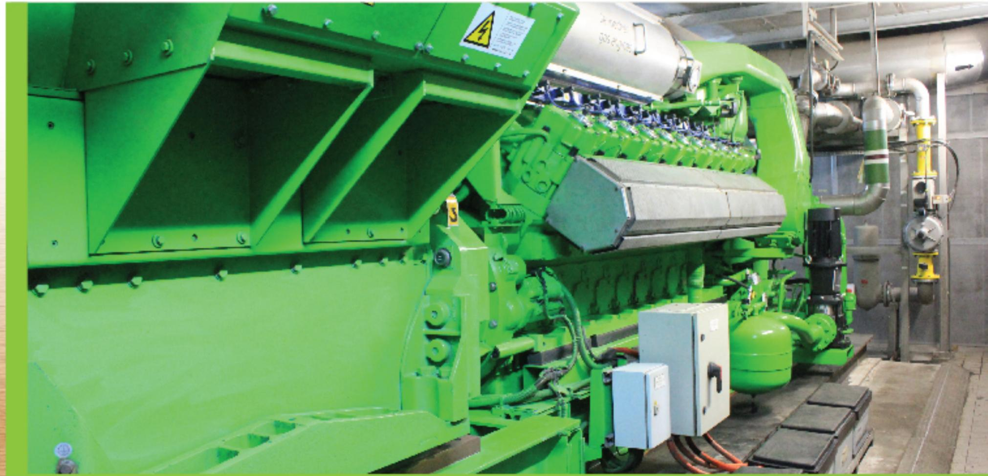
使用熱電聯供發電機，充分利用於處理污泥過程中所產生的沼氣作發電和發熱用途。
