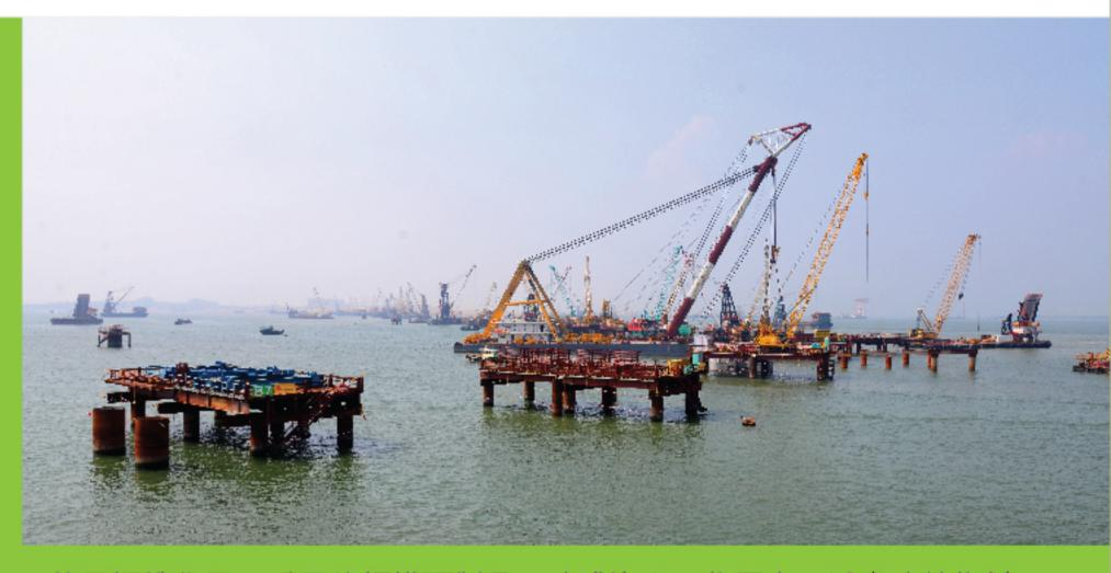
使用標準化及可重用的鋼鐵預製品,建成海上工作平台,減省建築物料。
