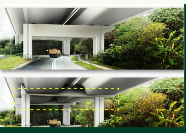
採用替代設計和施工方法,減少廢物產生和物料使用,例如採用甲板 / 橋墩整體連接的安排,移除高架橋墩和甲板之間的軸承,以及減少樁的數量和樁帽的尺寸。
