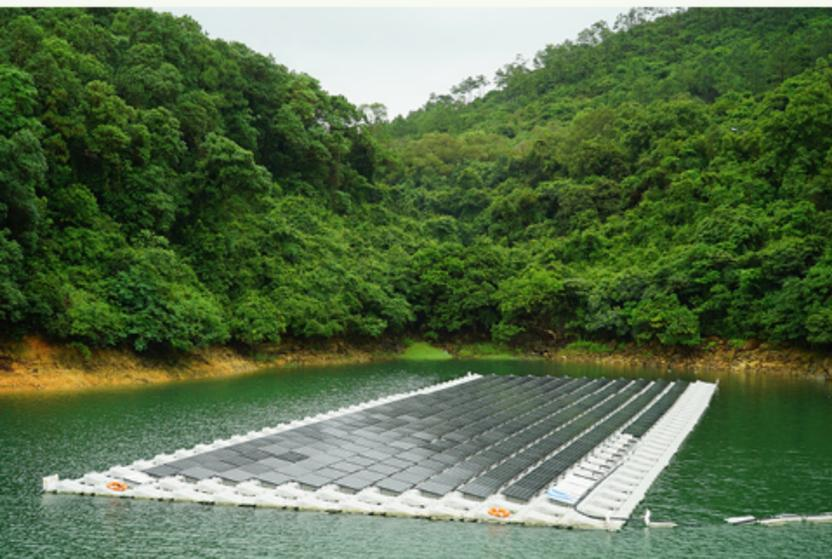
在石壁水塘安裝一百千瓦的浮動光伏板系統，提供能源支援附近石壁閘塔的水泵運作，同時有助減少水塘表面水分蒸發及改善水質。
