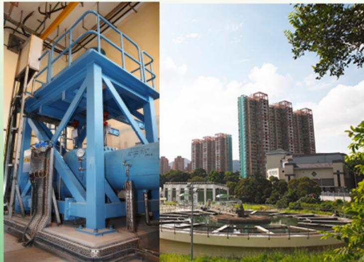
利用大欖涌水塘流入屯門濾水廠的水力作發電用途，以支援濾水廠部分電力需求。
