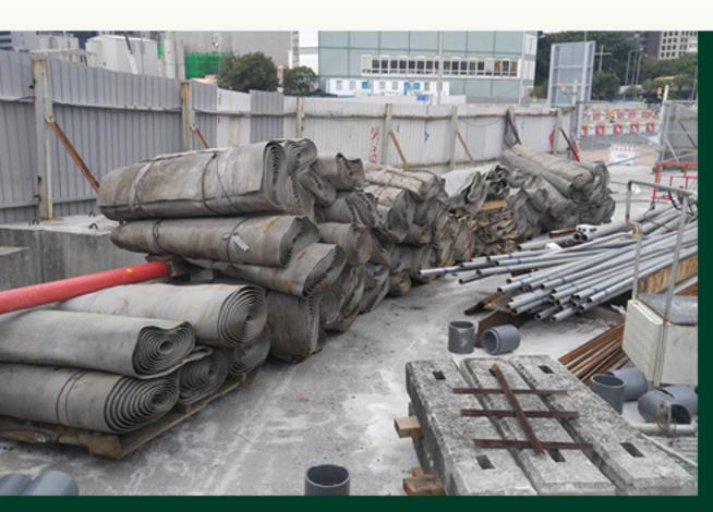
透過與其他工地協調,廣泛使用二手材料,包括隔音簾、 隔音毯、混凝土塊及板樁等。
