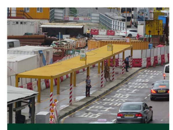
透過採用臨時交通管理方案的替代設計,改裝一個 集裝箱成為可重用的臨時巴士車站候車亭,減少路面 翻新和建造隔牆所耗的材料、產生的拆卸廢物以及 對周圍環境的滋擾。
