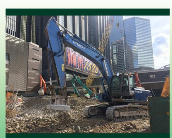
使用附電磁鐵的機器<sup>,</sup>提升從拆卸廢料中篩選出特定 金屬的效率,促進物料回收。
