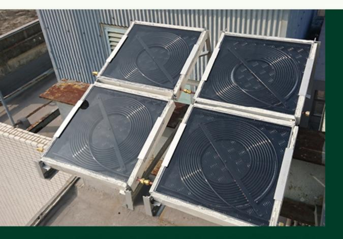
自行研發低成本的太陽能熱水系統,以銅管吸收太陽能加熱用 水從而達到節能效果。
