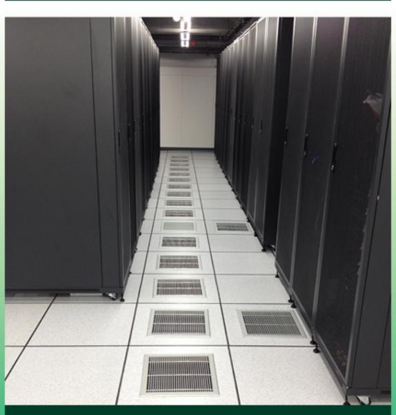
數據中心採用高架地板空調系統以達到最佳冷卻效果,並以冷熱通道設計改善空氣流動和通風,從而降 低能源需求。
