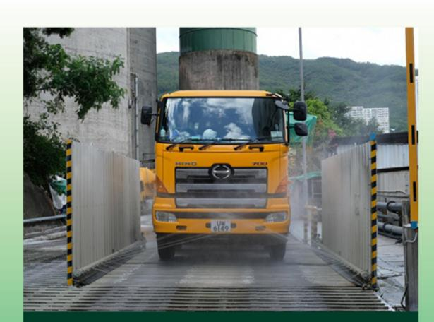
與鄰近公司合作,在工場出口安裝自動化輪胎清洗設備,確保工場車輛駛出道路時不帶塵土。
