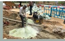
將收集到的廢棄玻璃樽,在屋苑內以玻璃破碎機打碎 成為玻璃砂,再用於屋苑內建築地盤的回填工程, 以減少廢物。
