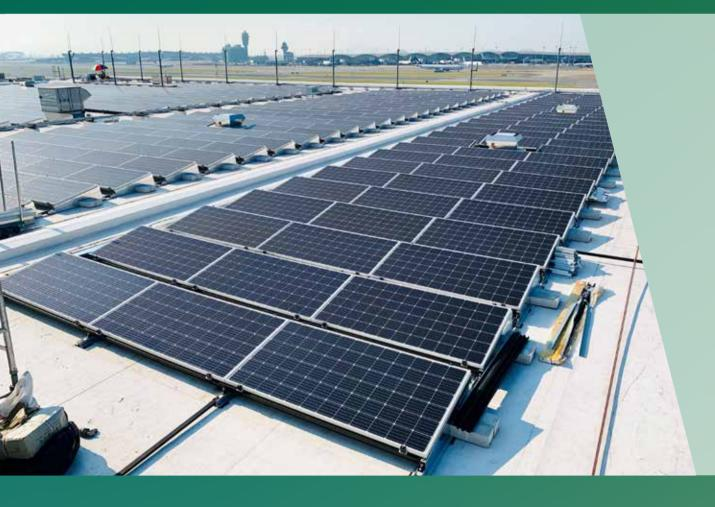
參加由中華電力有限公司推出的可再生能源上網電價計劃,在公司頂樓安裝太陽能發電系統並接駁至電網,每年可透過該系統產生322 000度電。
