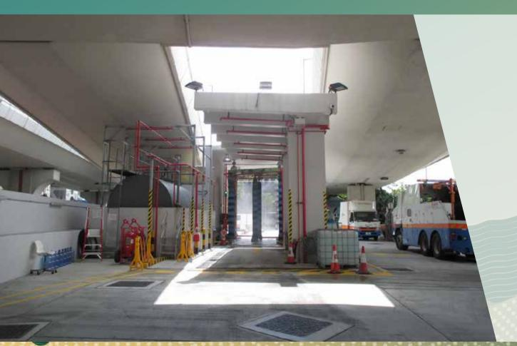
安裝雨水收集系統,從巴士廠天台及洗車機頂部 收集雨水,循環再用來清潔巴士廠房及巴士,節省 用水。
