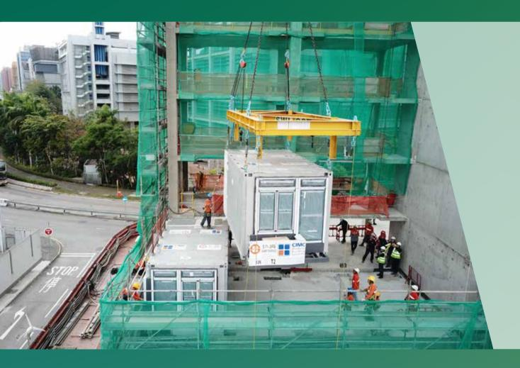
採用「組裝合成」建築法興建15層居住單位。「組裝合成」 的模組比全鋼筋混凝土類型輕,因此只需使用較少的能源 進行吊運和運輸,因而顯著降低碳排放。這種建築方法亦能 減少在廠房生產和現場施工過程中的材料浪費。
