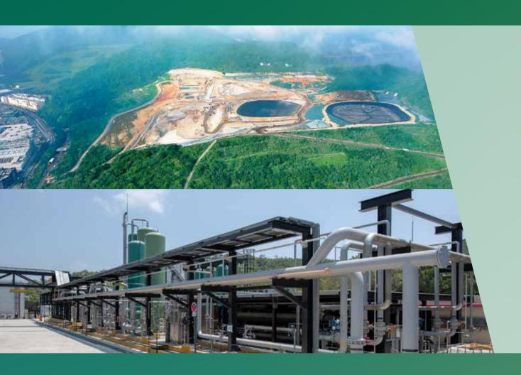
煤氣公司以創新技術發展多個轉廢為能項目,實踐「循環經濟」。其中在新界東南堆填區的沼氣應用項目,是全亞洲同類型規模最大的項目。這個轉廢為能的項目避免了在堆填區內直接燃燒沼氣所造成的資源浪費及碳排放,同時每年最多可取代13 000噸石腦油用量及減少56 000噸溫室氣體排放。
