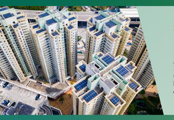
於2017/18年度參與中電可再生能源上網電價計劃,並在12棟住宅樓宇頂部安裝902塊太陽能板。2018/19年度共獲得超過145 000度電,約佔總能源耗用量的5.6%。
