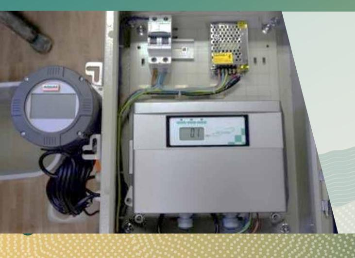
設有實時污水監測和數據記錄系統,監測工地污水 質量。當污水質量超出排放標準,技術團隊會即時 收到通知,以便調查原因及儘快作出修正。
